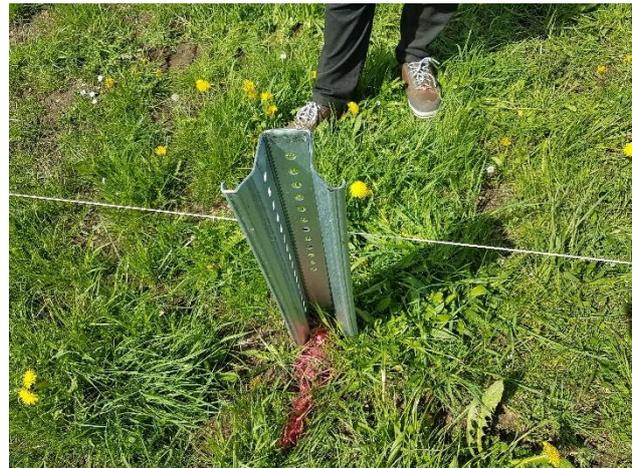
Abbildung 5: Rammfundament
