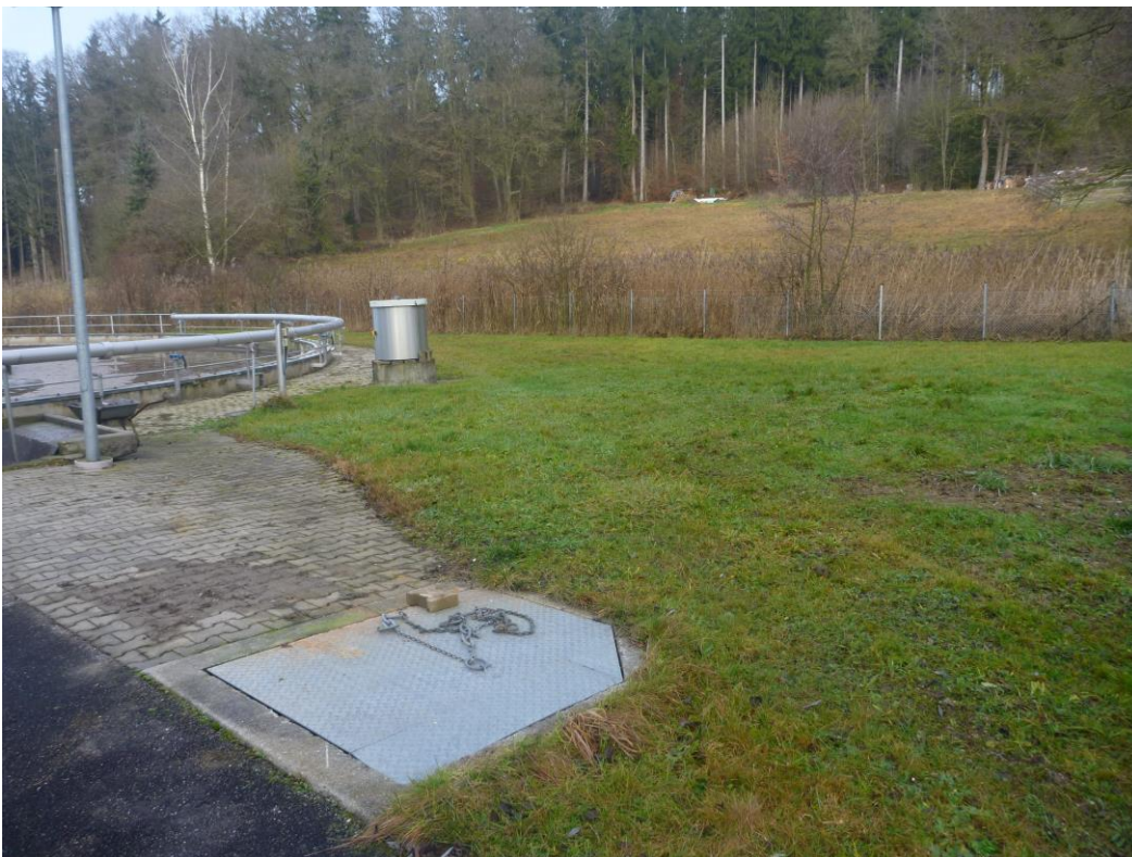
Abbildung 3: Einzäunung Kläranlagengelände außerhalb der Landröhrchte; Blickrichtung Nordwest
