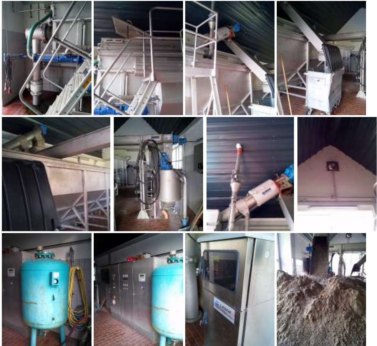
Abbildung 2: Fotodokumentation Rechen-Sandfang-Kompaktanlage
